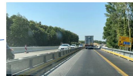
Circulation à double sens sous basculement de la circulation.
